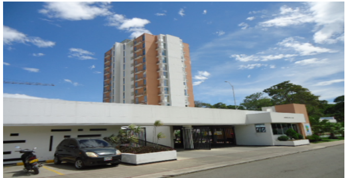
Fachada del Inmueble
