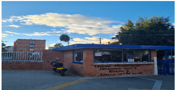
Fachada del Inmueble
