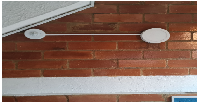
Detalle de acabados
