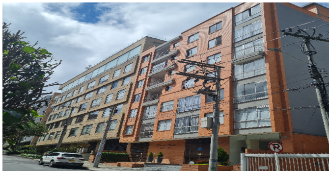
Fachada del Inmueble
