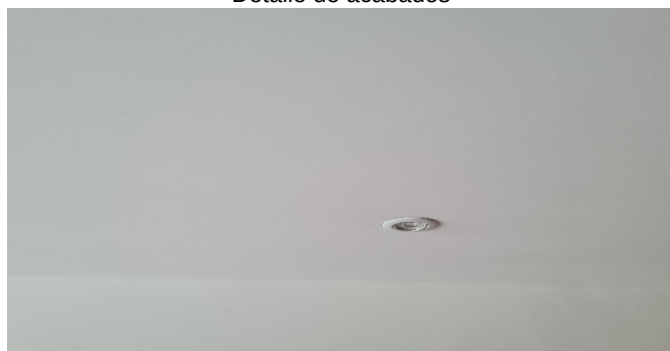
Detalle de acabados
