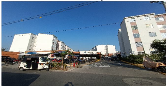
Fachada del Conjunto
