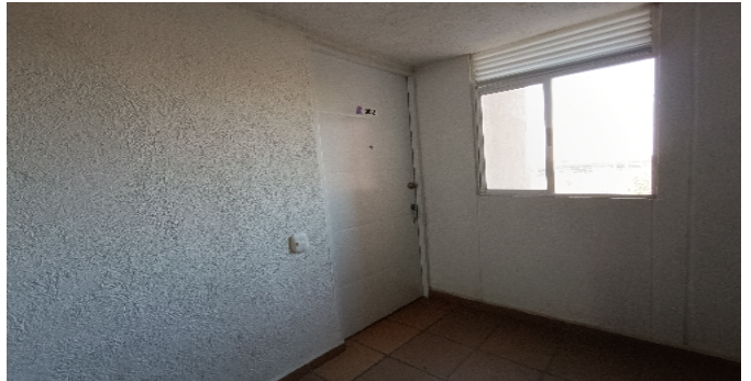
Fachada del Inmueble
