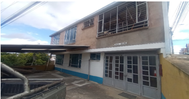
Fachada del Inmueble
