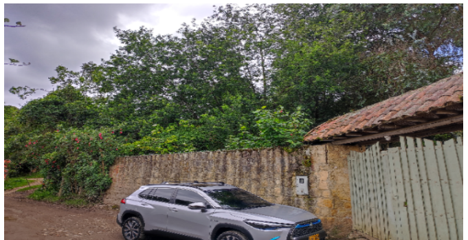
Fachada del Inmueble
