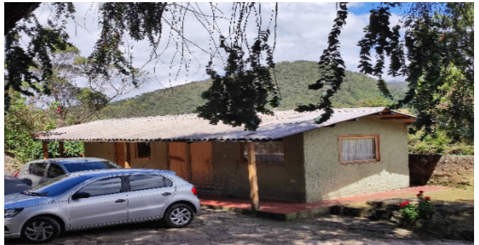
FACHADA CASA CUIDADOR
