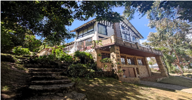
Fachada del Inmueble
