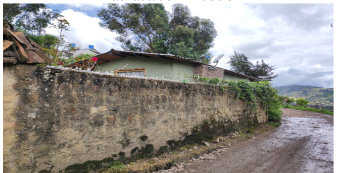
Fachada del Inmueble
