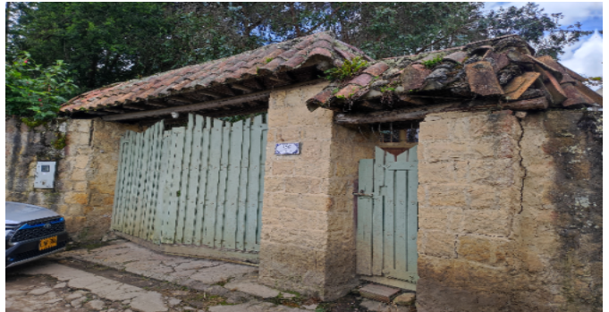
Fachada del Inmueble
