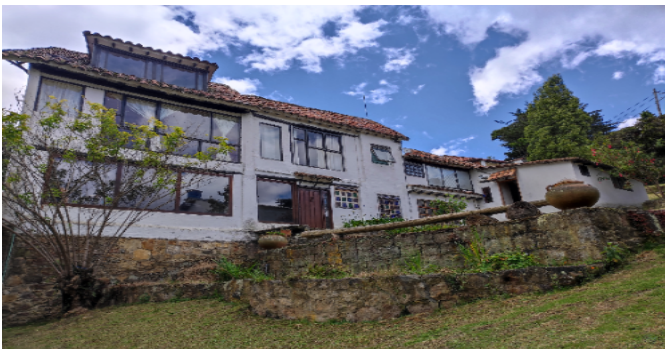
Fachada del Inmueble
