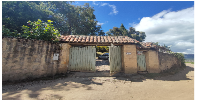
Fachada del Inmueble
