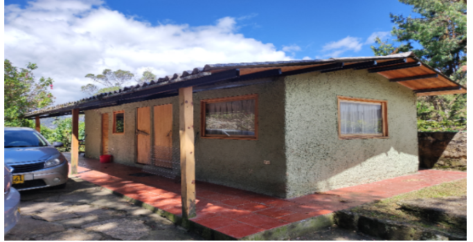
FACHADA CASA CUIDADOR
