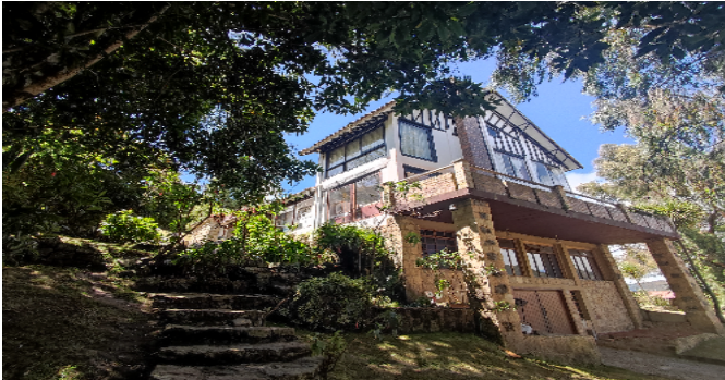
Fachada del Inmueble
