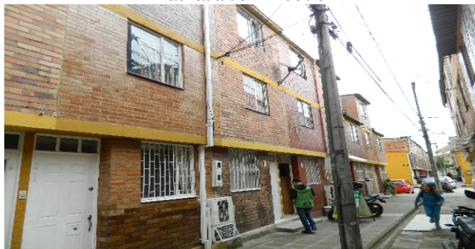
Fachada del Inmueble
