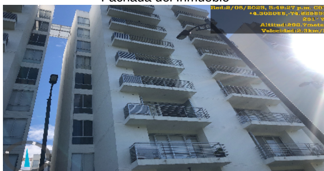
Fachada del Inmueble
