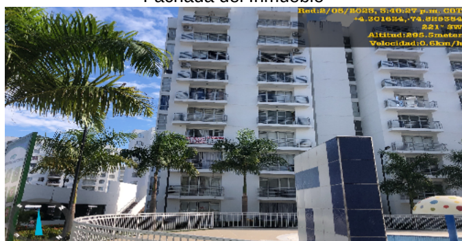
Fachada del Inmueble
