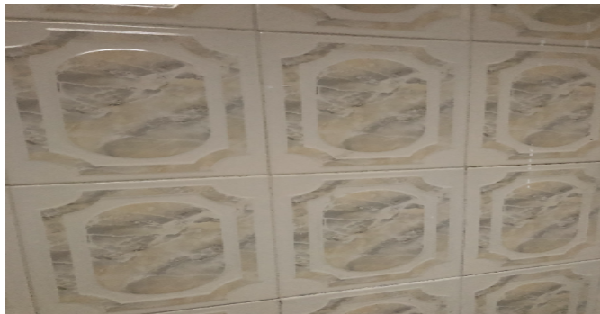
Detalle de acabados
