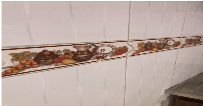
Detalle de acabados
