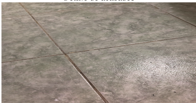
Detalle de acabados
