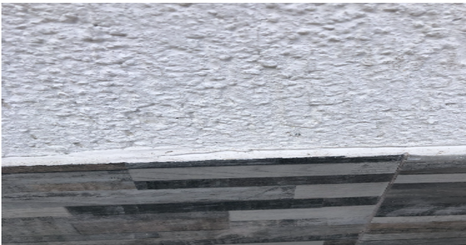
Detalle de acabados
