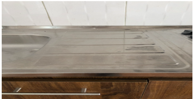
Detalle de acabados
