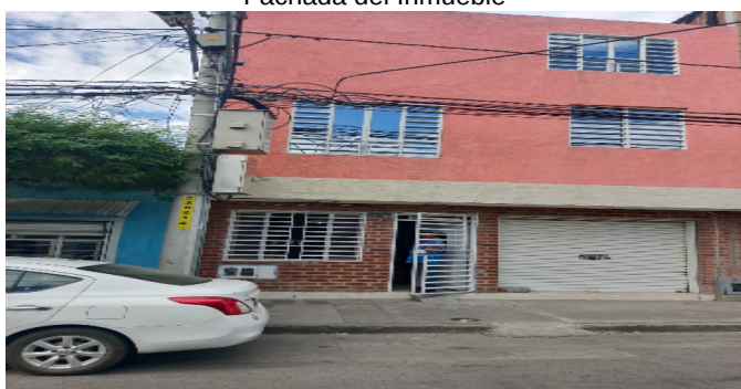
Fachada del Inmueble
