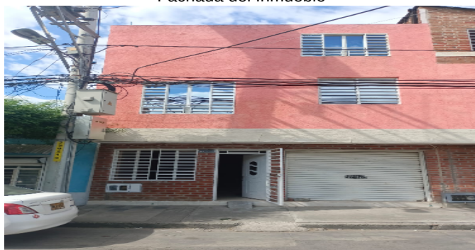
Fachada del Inmueble
