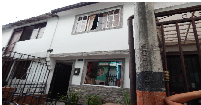
Fachada del Inmueble
