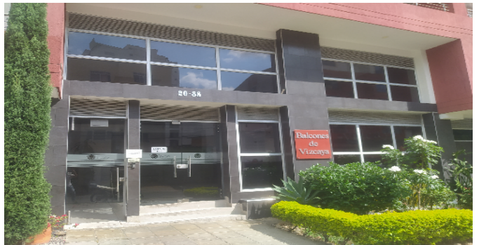
Fachada del Inmueble
