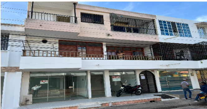
Fachada del Inmueble
