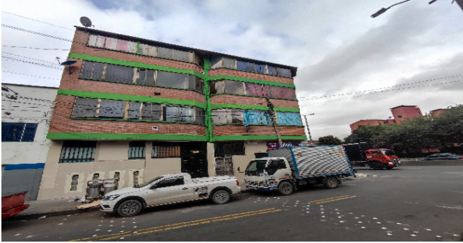
Fachada del Inmueble
