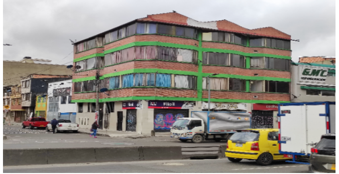
Fachada del Inmueble
