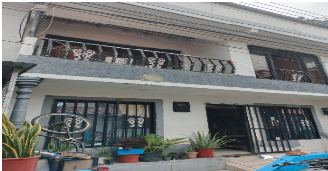
Fachada del Inmueble
