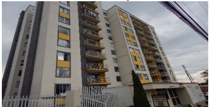
Fachada del Conjunto
