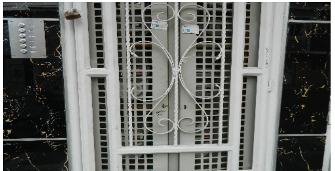
Contador de Gas
