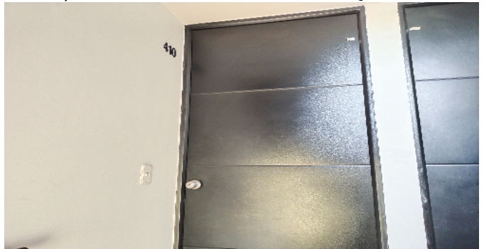
puerta de entrada APTO 410 BLOQUE 2B
