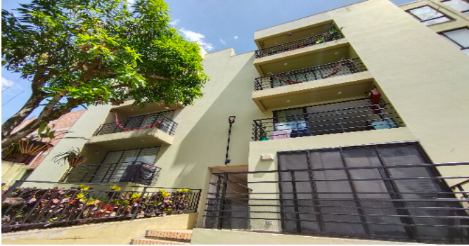
fachada de la torre APTO 306 BLOQUE 3A
