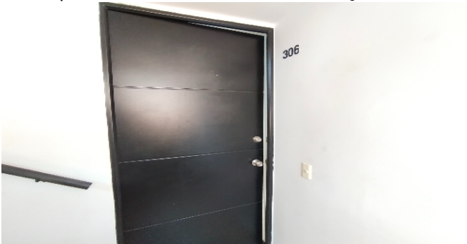
puerta de entrada APTO 306 BLOQUE 3A
