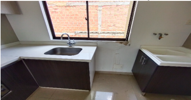
detalle de acabados APTO 306 BLOQUE 3A
