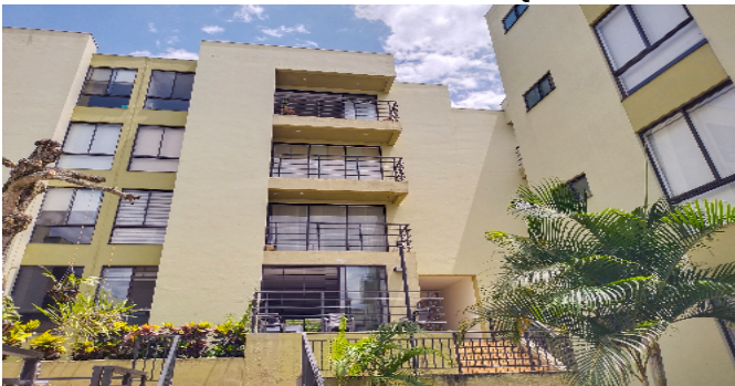
fachada torre APTO 309 BLOQUE 3B
