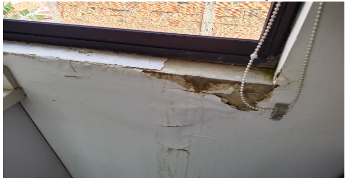
detalle de acabados APTO 306 BLOQUE 3A
