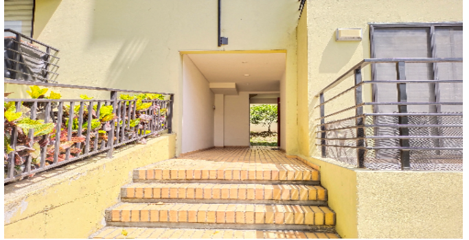
Entrada a la torre APTO 306 BLOQUE 3A
