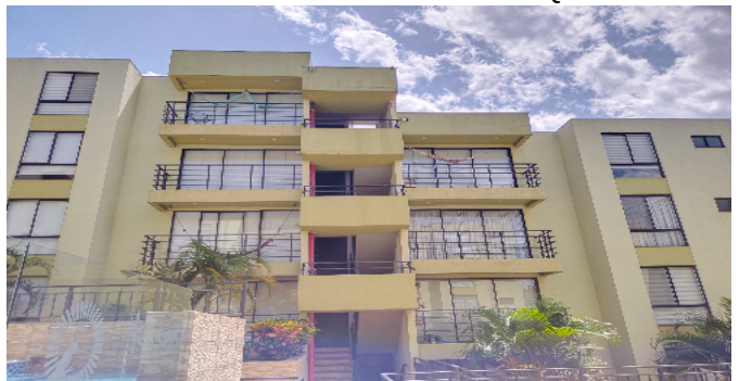
fachada de la torre APTO 410 BLOQUE 2B
