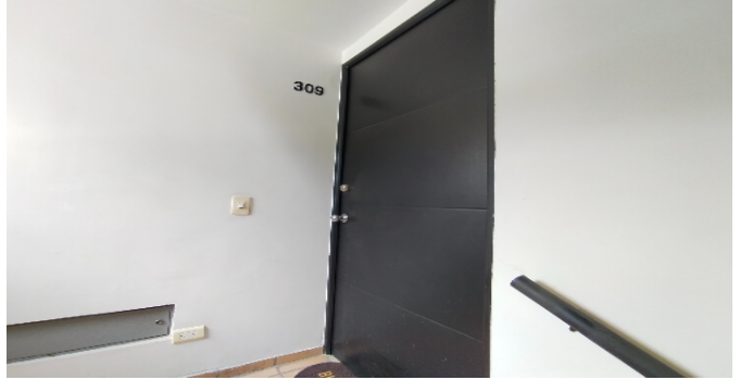
puerta de entrada APTO 309 BLOQUE 3B
