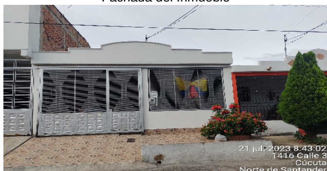
Fachada del Inmueble
