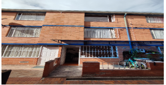
Fachada del Inmueble
