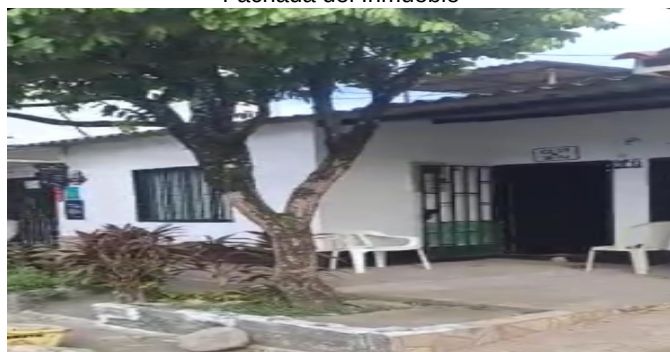
Fachada del Inmueble
