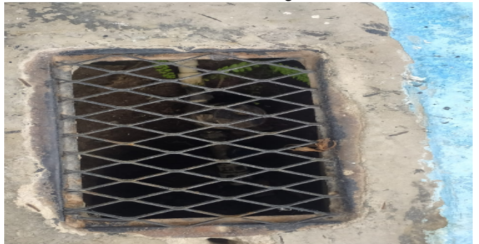
Contador de Agua
