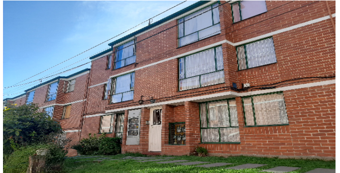
Fachada del Inmueble
