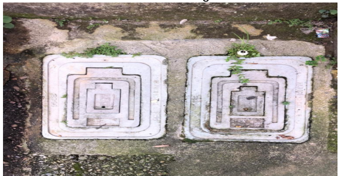
Contador de Agua
