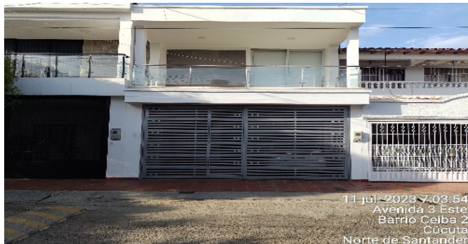
Fachada del Inmueble
