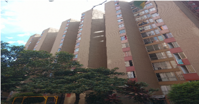
Fachada del Inmueble
