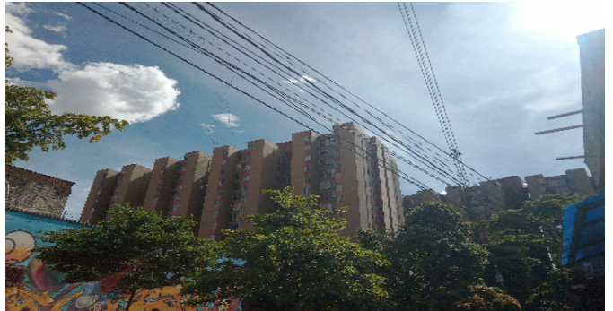
Fachada del Inmueble
