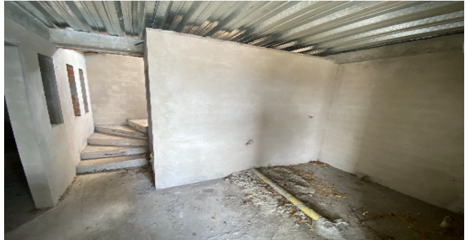
Baño privado habitacion 3
