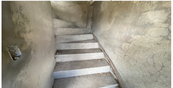
Escaleras Segundo piso
