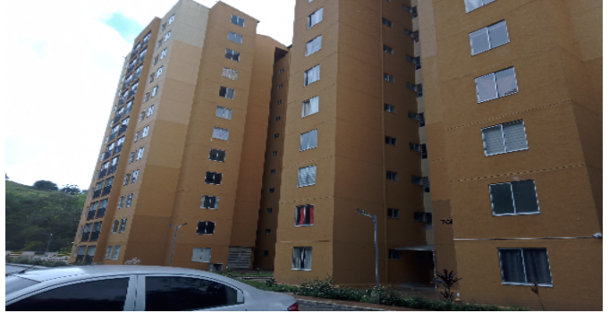
Fachada del Conjunto
