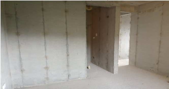
Puerta Hab principal
