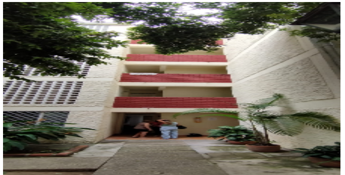
Fachada del Inmueble
