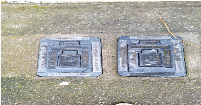
Contador de Agua
