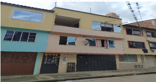
Fachada del Inmueble
