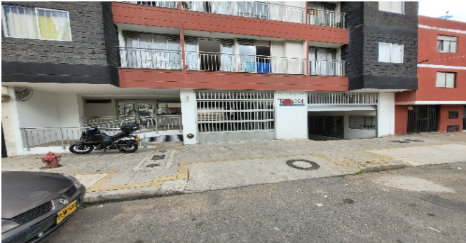
Fachada del Inmueble
