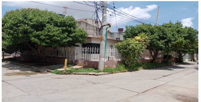
Fachada del Inmueble
