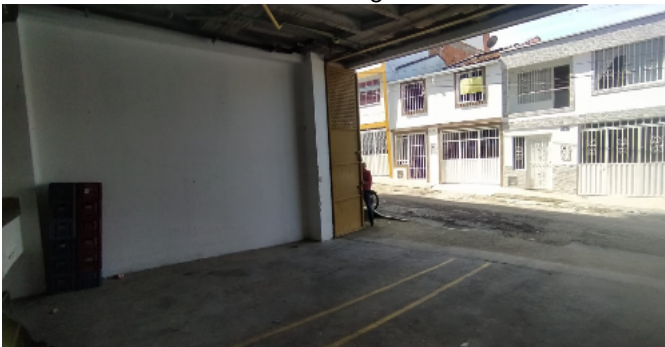
Zona de descarga Nivel 1
