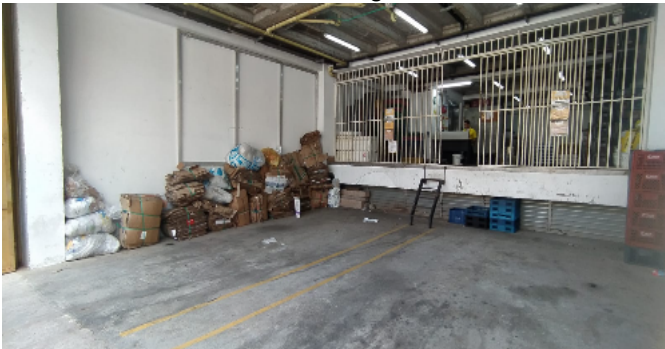
Zona de descarga Nivel 1
