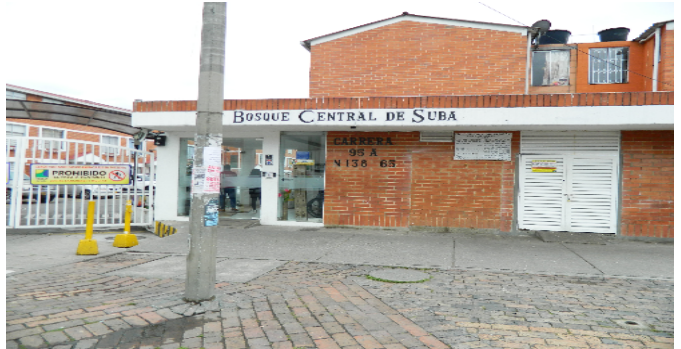
Fachada del Inmueble
