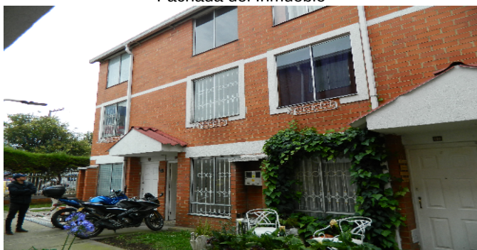
Fachada del Inmueble
