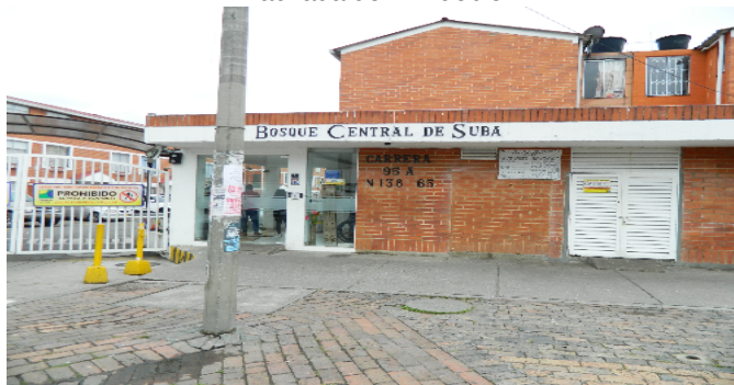
Fachada del Inmueble
