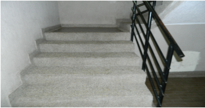
Escalera comn CJ
