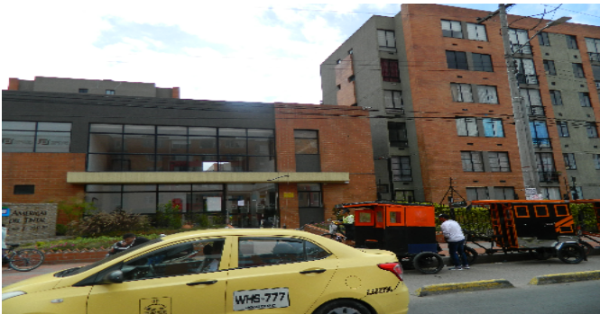
Fachada del Inmueble
