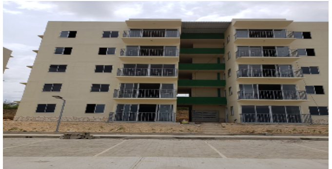
Fachada del Inmueble
