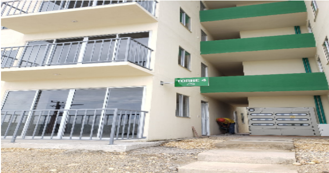
Fachada del Inmueble
