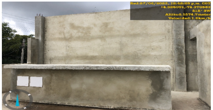
LOBBY DEL EDIFICIO SIN TERMINAR
