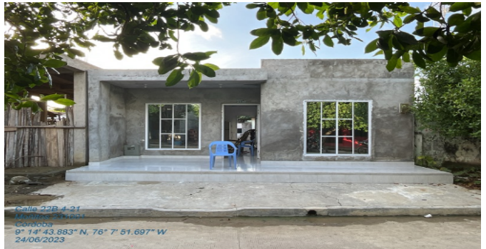
Fachada del Inmueble
