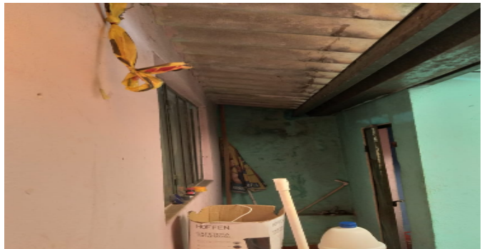
Detalle de acabados
