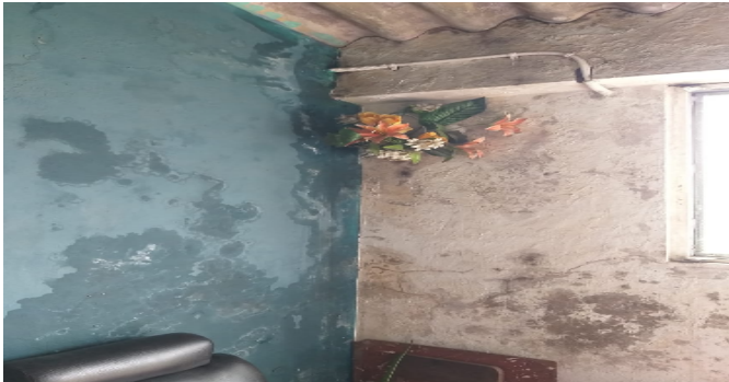
Detalle de acabados
