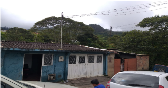
Fachada del Inmueble
