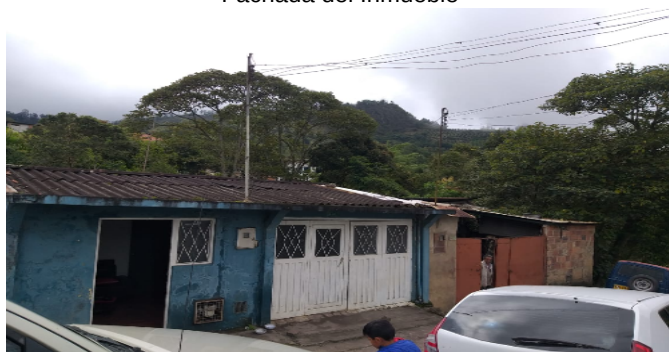
Fachada del Inmueble
