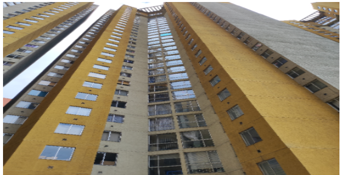
Fachada del Inmueble
