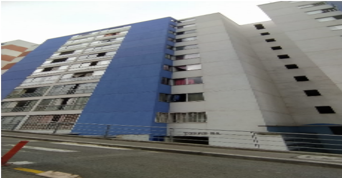
Fachada del Inmueble
