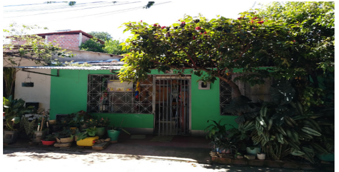
Fachada del Inmueble
