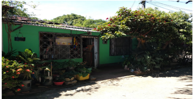
Fachada del Inmueble
