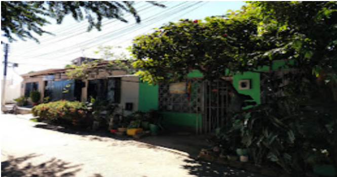
Fachada del Inmueble
