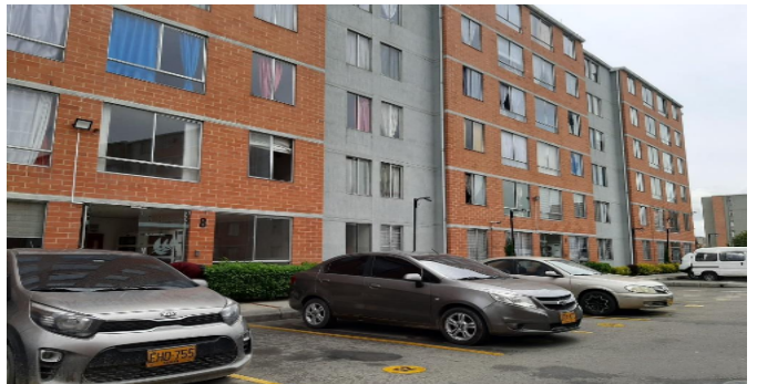
Fachada del Inmueble
