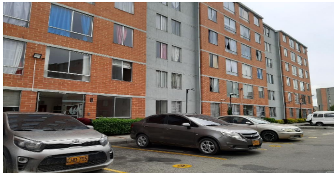
Fachada del Inmueble
