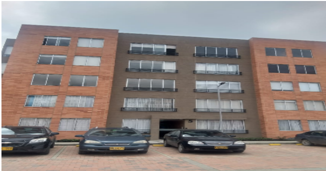
Fachada del Inmueble
